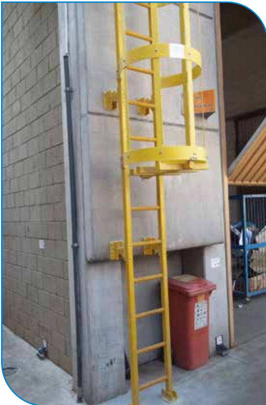
Esperas de compósitos chumbadas diretamente na parede
