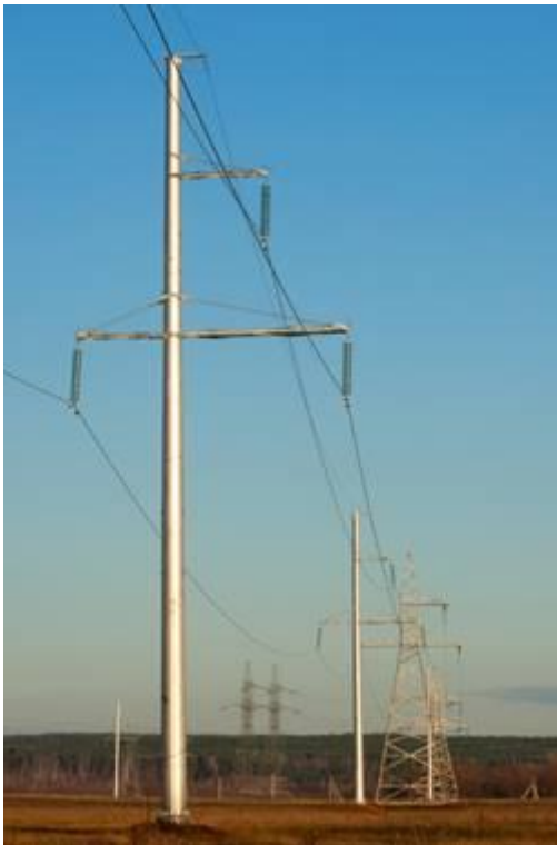
Postes e cruzetas: compósitos têm crescido como materiais substitutos do concreto e madeira
